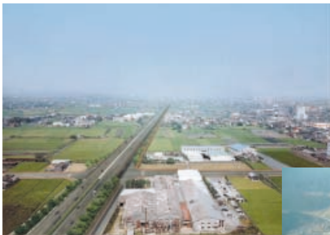
整備が進む有明海沿岸道路
