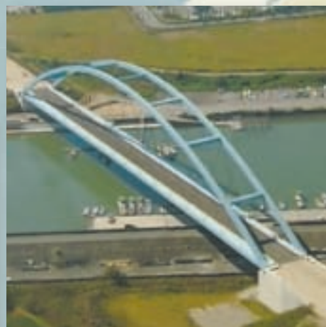
有明海沿岸道路(堂面川橋)
