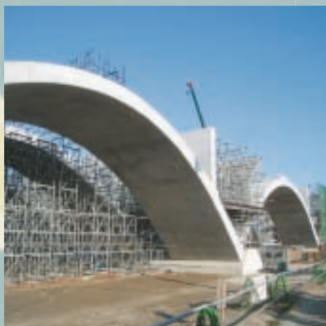
有明海沿岸道路(高田大和バイパス)
