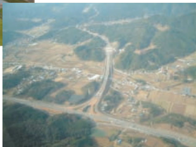
平成16年に全通した長崎自動車道
