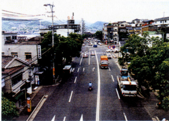
▲ 国道202号から見た計画地区 (左がA街区、右がB街区)
